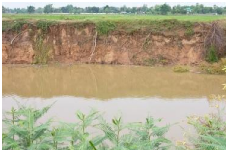
Erosão causada pela retirada da mata ciliar nas proximidades de um rio
